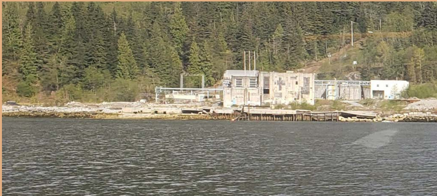
Woodfibre LNG site – Apr 2022
